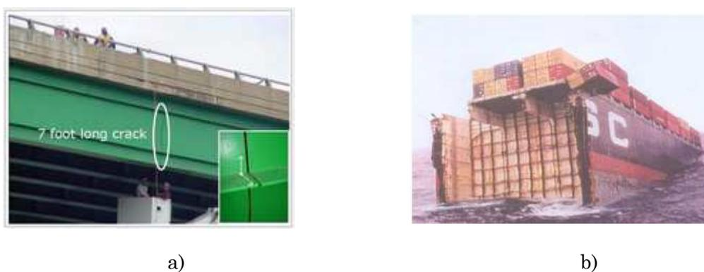
Figura 1.5. a) Fisura generada por fatiga en un puente [11] y b) Rotura generada por fatiga en el barco MSC CARLA [12].
