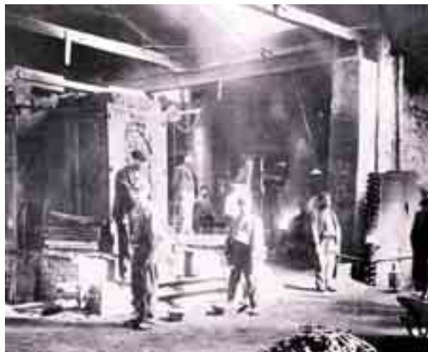
La fundición de Unión Cerrajera de Mondragón en 1910, eslabón de la tradición industrial de la comarca.
