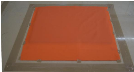
Figura 4.7 Colocación del peel-ply sobre el refuerzo.
