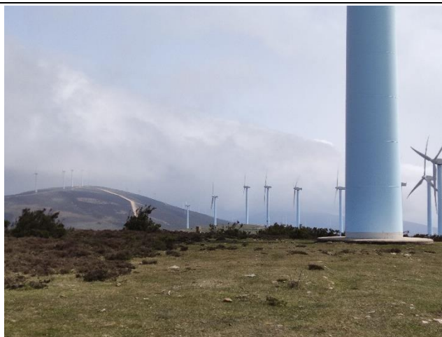
Figura. 16. Parque eólico de Elgea, ubicado en la provincia de Alaba y que está formado por molinos de viento tri-pala (uno de los primeros parques eólicos instalados en España).
